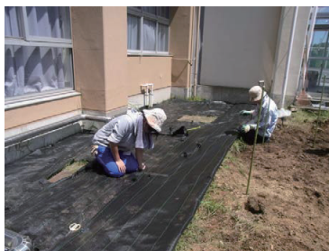
写真3 防草シート設置(8月27日)
