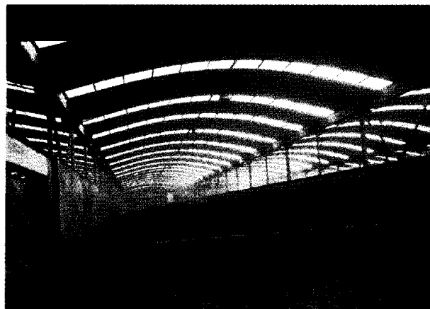
写真一15 堆肥化处理施設
