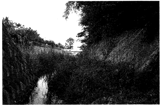
図-4 コンクリート護岸部
